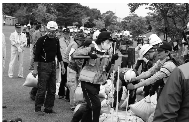
土のう作成、 積み土のう工法訓練
