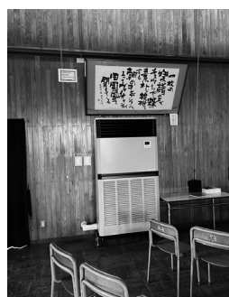
エアコンの新規設置
