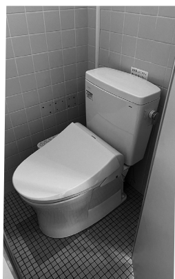
校舎内トイレの新規設置
