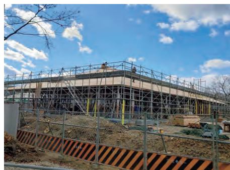
建設中の「なすとらん」
