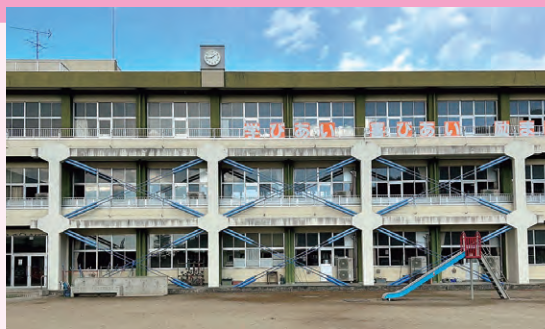
町立小中学校で順次工事が始まる
