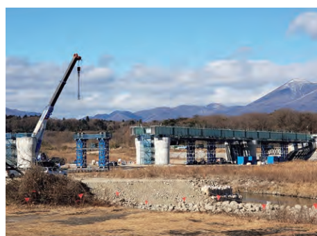
開通が待たれる（仮称）那珂川橋
