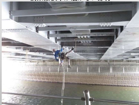
— 橋梁点検車が届かない部材 —
