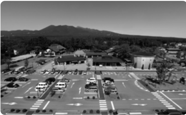
道の駅那須高原友愛の森（全景）
