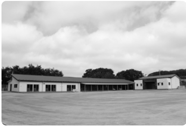
高久地区に整備された「なすのそら保育園」
