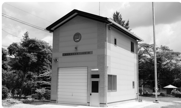
新築した消防団詰所（上下田地区）
