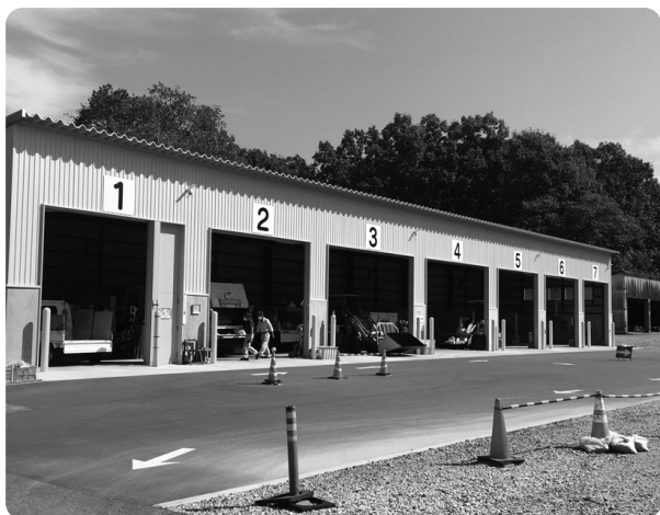
新築したストックヤード（クリーンステーション那須）
