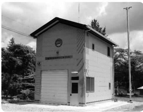
新築した消防団詰所
