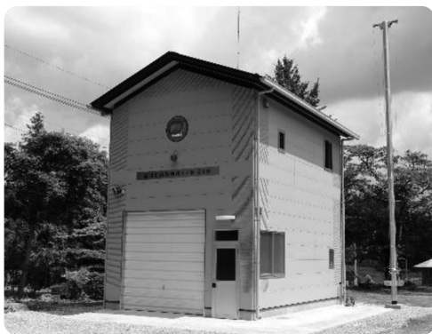
新築した消防団詰所
