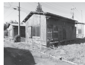
取り壊し予定の上の原第2団地
