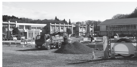
建設が始まった統合保育園
