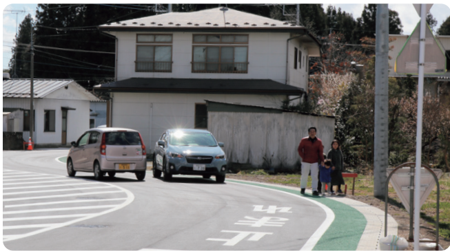
黒田原・高久駅線道路改良
