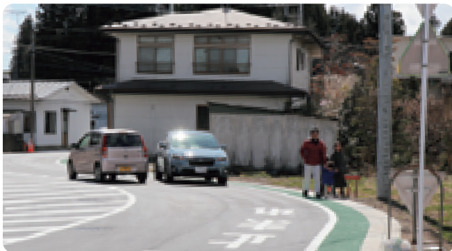
黒田原・高久駅線道路改良
