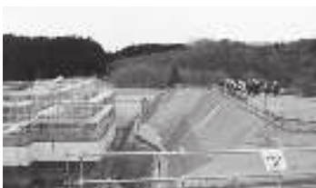
整備が進む 共同一般廃棄物最終処分場
