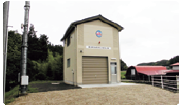
新築した消防団詰所（高瀬地区）
