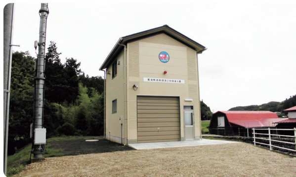
新築した消防団詰所（高瀬地区）
