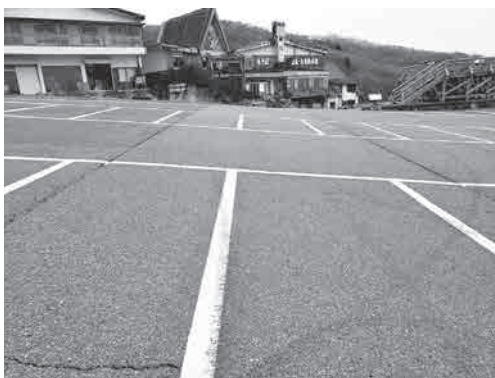
インフラ整備が求められる大丸駐車場
