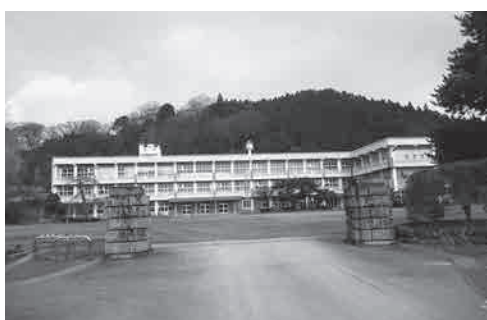
解体工事が待たれる旧伊王野小学校舎
