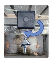
る)にし、蛇口を開けて中の水を 上のバルブを「水抜き」 水抜きができるタイプの蛇 (閉め 口は
