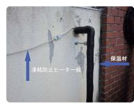
があるので注意してください。 りすると、そこから凍結すること 販の保温材を巻き、その上からビ してある場合は、忘れずにコンセ る場合でも、一部が剥がれていた です。すでに保温材が巻かれてい トにプラグを挿入しスイッチを ールテープなどを巻くと効果的 また、凍結防止ヒーターが設置 水道管や蛇口には厚手の布や市
