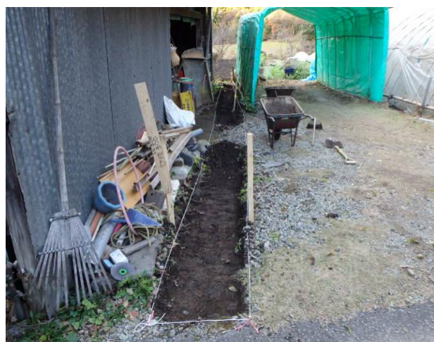
雨だれの削り取り状況
