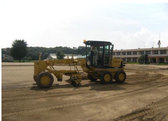
グラウンドの表土除去作業
