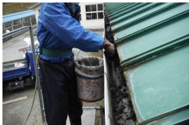
雨樋の堆積物除去
