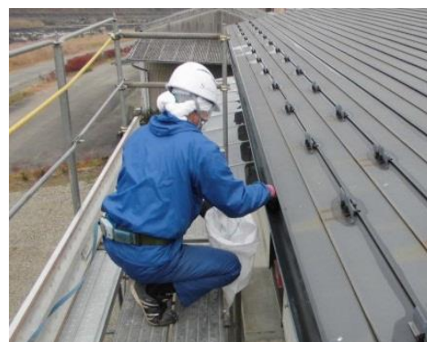
雨樋の堆積物除去
