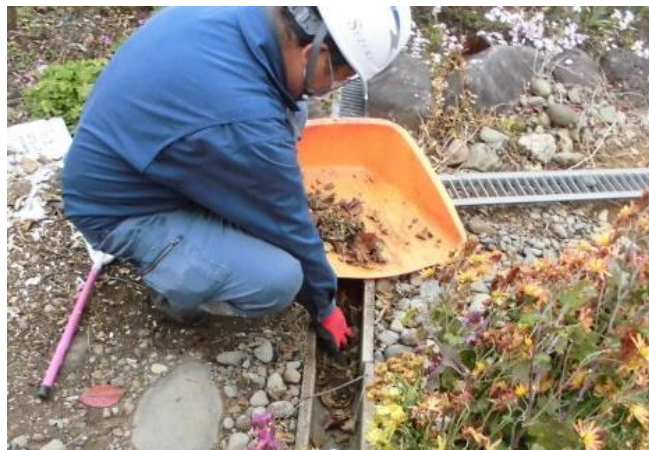
側溝の堆積物除去
