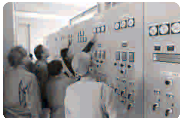
12/6 湯本占勝園浄水場視察 (産業建設観光常任委員会所管)
