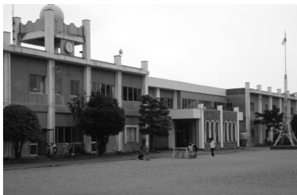
改修される高久小学校校舎
