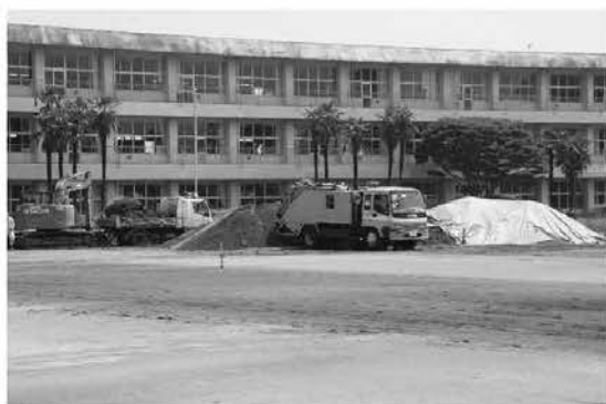
小学校校庭の表土除去（黒田原小学校）
