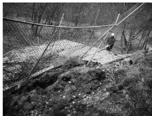
被災した旧黒田浄水場の調査を実施
