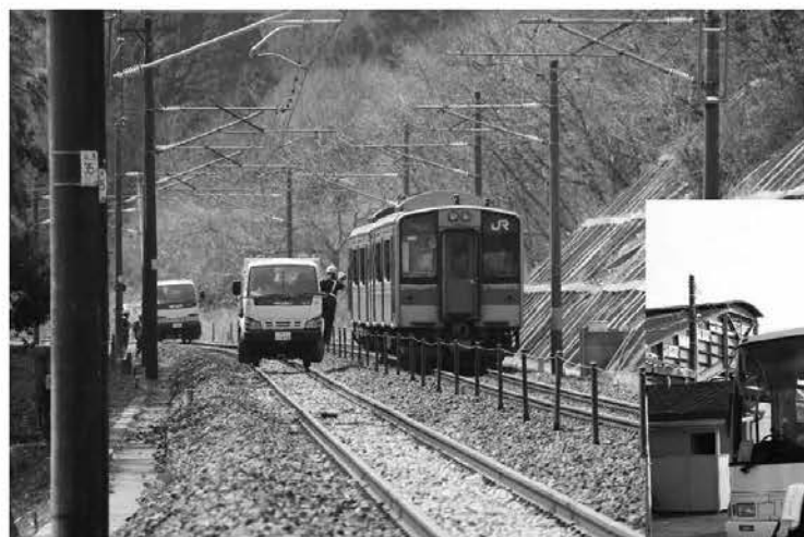
JR 東北線崩落現場（水原）
