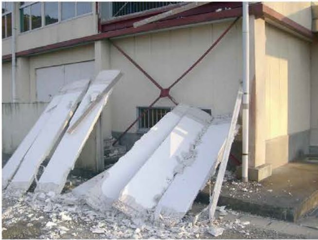
校舎に亀裂が入ったり、体育館の壁が落下するなどの被害を受けた町立小中学校。
