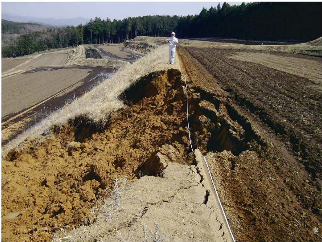
地震により水田畦畔の崩落や田面の地割れ、用水路の破損など、農地・農業用施設にも大きな被害が発生した。
