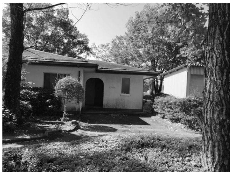
バリアフリーが望まれる管理事務所
