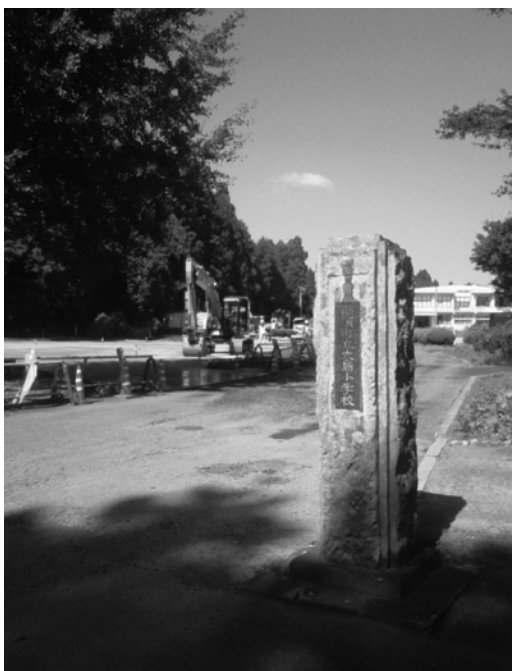
来年度開校に向けての拡幅工事（大島小学校）
