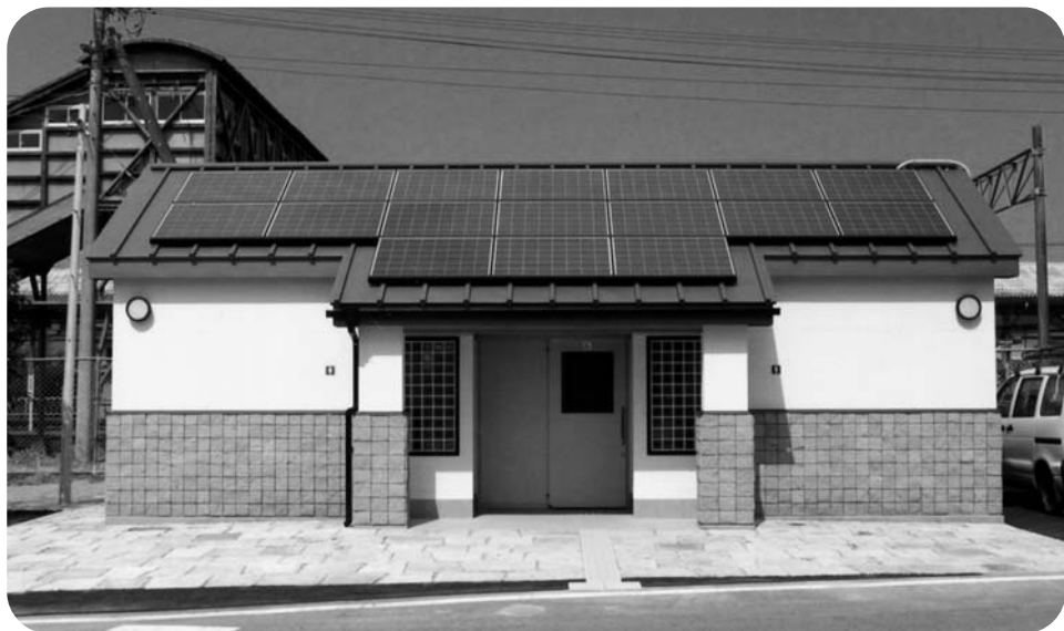
黒田原駅前公衆トイレ (太陽光発電)
