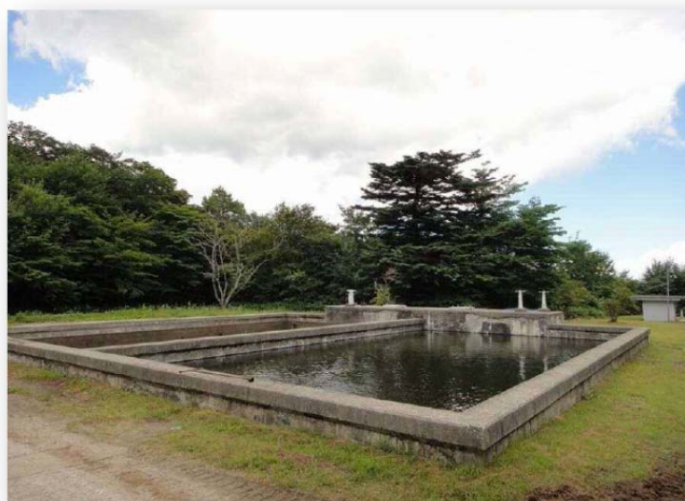
十石平浄水場 緩速ろ過池
